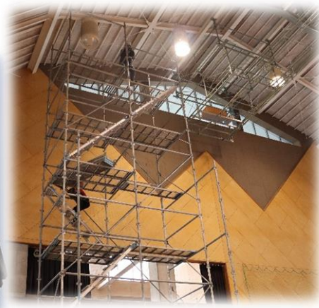
【体育館照明の交換】
